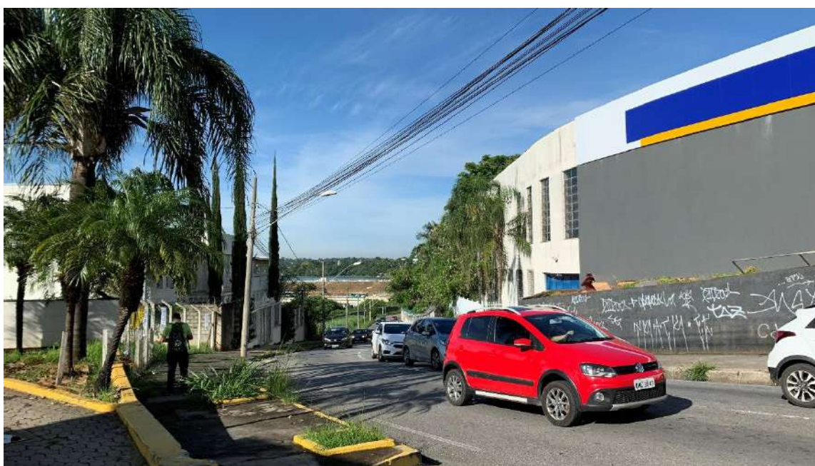
Rede elétrica e edificação na calçada da frente
