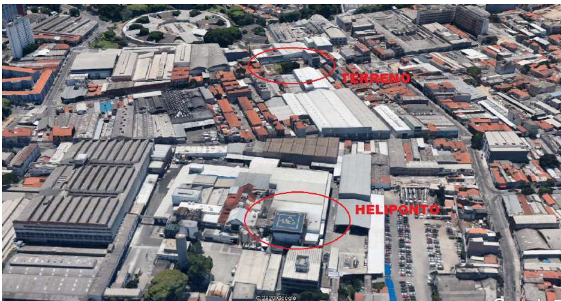
Heliponto privado no Brás, São Paulo, interferindo em terreno vizinho
